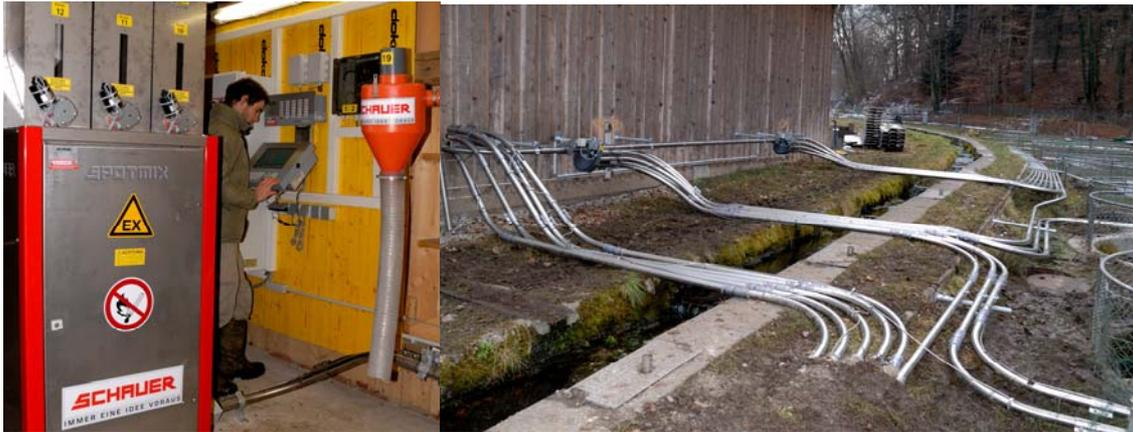
*Moderne Fütterungstechnik: Fütterungszentrale (links) und Futterrohre (rechts)*
