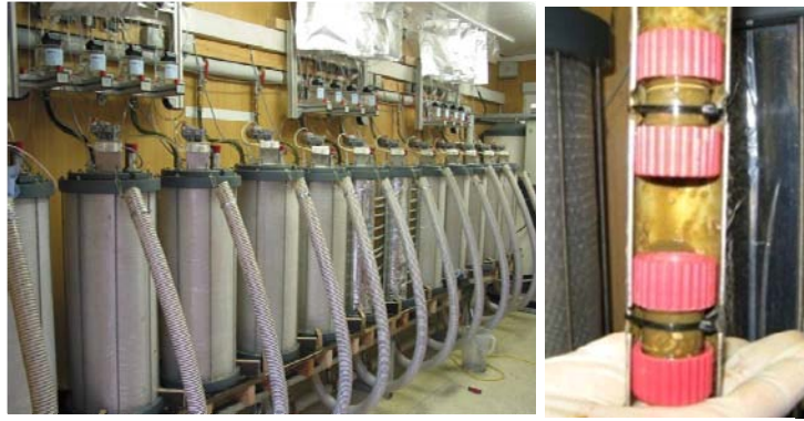
Links: Durchfluss-Versuchsbiogasfermenter (Foto: ILT); rechts: zwei übereinander, für die Montage im Fermenter in einer Haltevorrichtung befestigte Diffusionskeimträger
