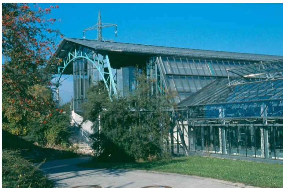
Betriebsgebäude der Arbeitsgruppe „Krankheiten, Schädlinge bei Obst, Gemüse, Zierpflanzen und Baumschulen“
