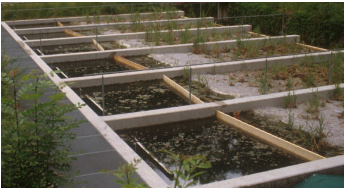
Bodensystempflanzenkläranlage mit vorgelagertem Absetzbereich
