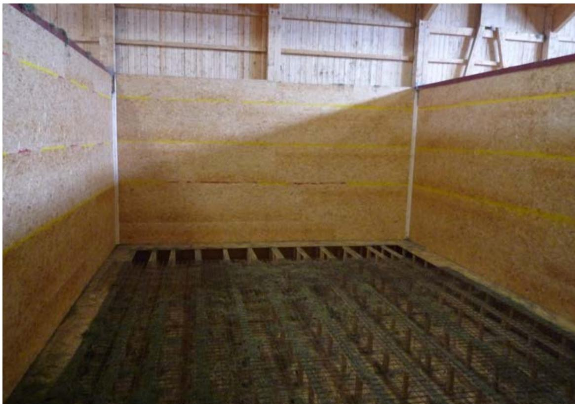
Abb. 1: Leere Heubelüftungsbox mit Bodenkonstruktion
