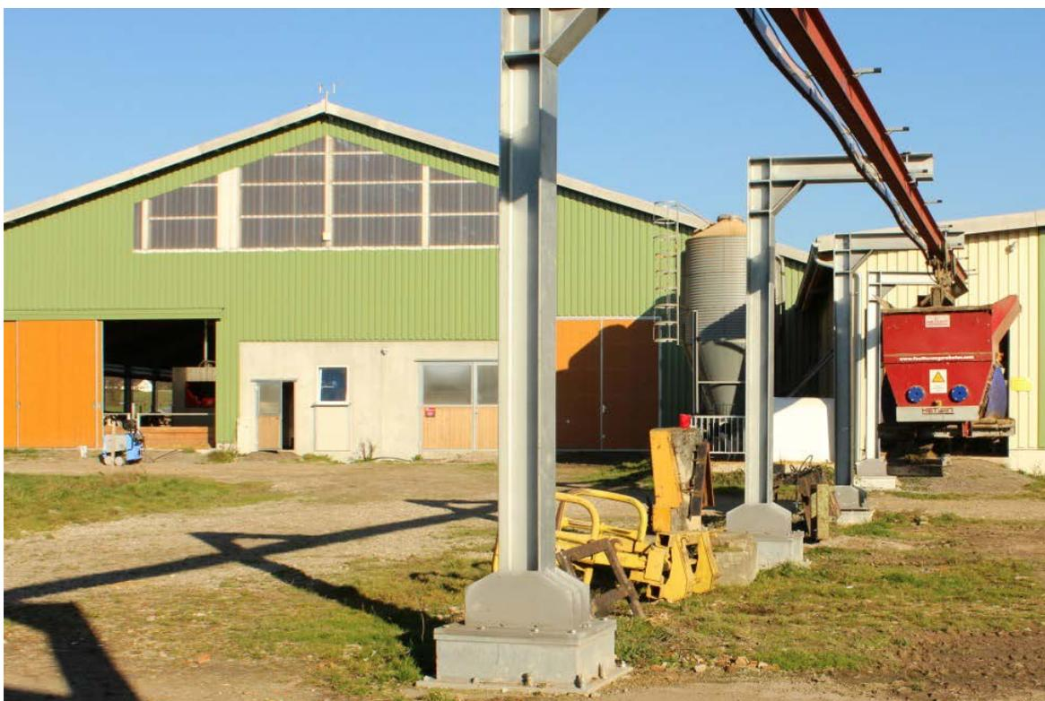
Abb. 3: Stallaußenansicht mit schienengeführtem Futterwagen
