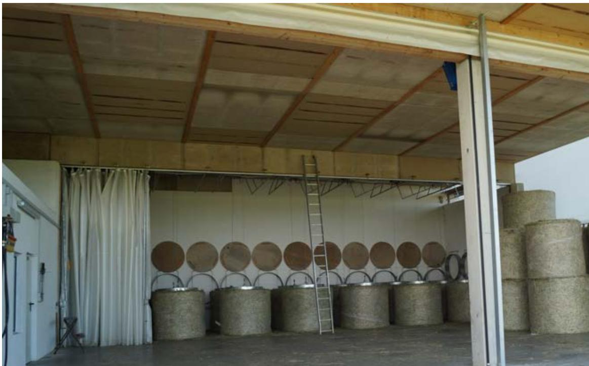
Abb. 2: Rundballenbelüftung mit Vorhang für Umluftbetrieb
