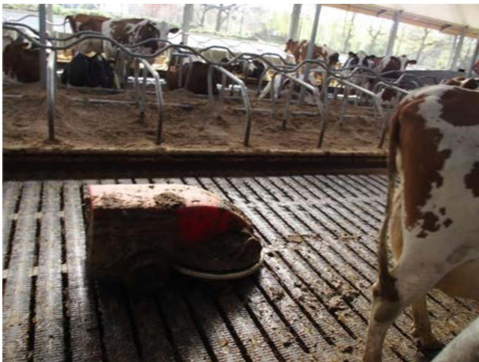
Abb. 2: Emissionsarmer Spaltenboden mit Reinigungsroboter, Bild: Eurich-Menden
