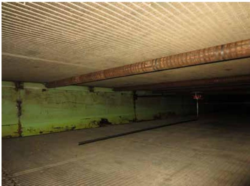
Abb. 62: Kapazitive Feuchtigkeitsmessung mittels einer Messlanze im Bandrockner
