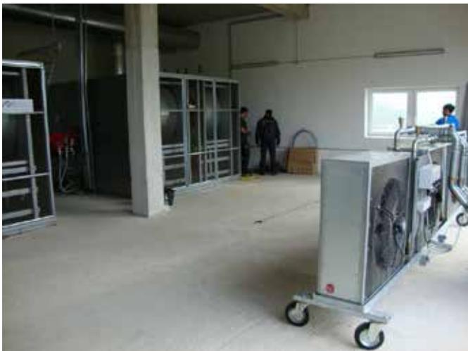
Abb. 73: Positionierung eines Warmwasser-Heizregisters mit Gebläse im Ansaugluftstrom zweier Warmluftferzeuger
