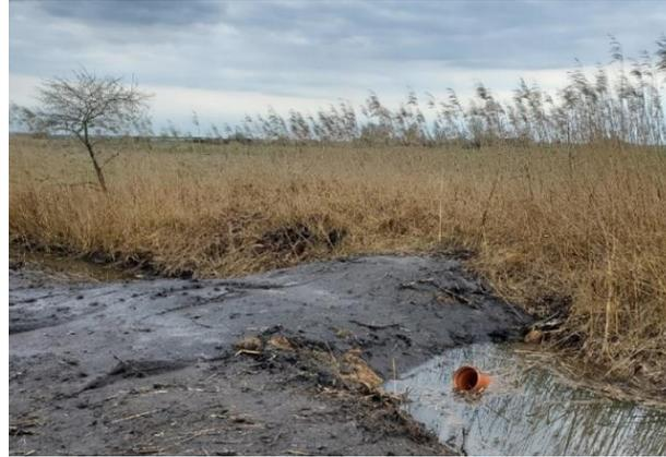
*Abbildung 25: Umsetzung eines Dammes aus Lehmmaterial. Der Dammkörper ist durch Kokosmatten an der Oberfläche vor Erosion geschützt. Eine Mulde auf der Oberfläche ermöglicht den Abfluss im Hochwasserfall und garantiert so die Stabilität des Dammes.*
