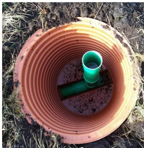
*Abbildung 20: Ein Kunststoffschacht bestehend aus einem Schachtrohr und Steigrohr zur Regulierung des stromaufwärts gelegenen Flächenwasserstandes.*
