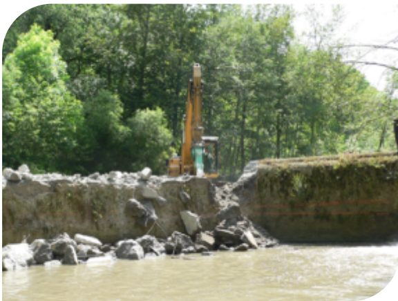
Abriss des HSM-Wehrs an der Peitnach.
