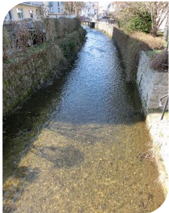
Einige hundert Meter flussabwärts verläuft dasselbe Gewässer innerhalb hart verbauter Ufer strukturlos und geradlinig völlig naturfern dahin. Hier finden Fischen nur sehr schlechte Lebensraumbedingungen.
