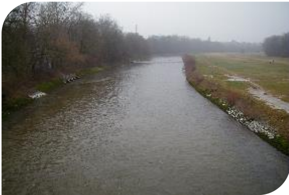
Das kanalartige Gewässerbett der Isar im innerstädtischen Bereich vor Durchführung der naturnahen Flussbaumaßnahmen.
