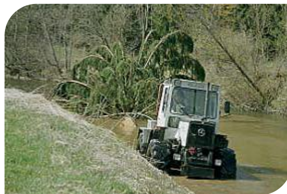
Eine frisch gefällte Fichte auf dem Weg zur Einbaustelle.
