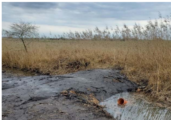
Abbildung 25: Umsetzung eines Dammes aus Lehmmaterial. Der Dammkörper ist durch Kokosmatten an der Oberfläche vor Erosion geschützt. Eine Mulde auf der Oberfläche ermöglicht den Abfluss im Hochwasserfall und garantiert so die Stabilität des Dammes.
