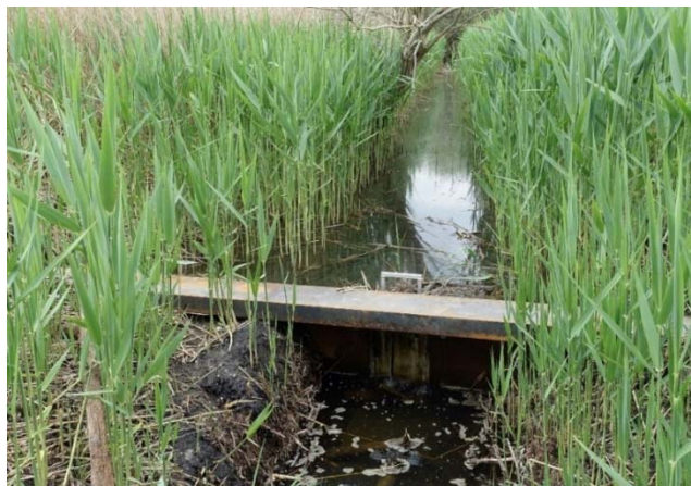
Abbildung 23: Die an die Flächen grenzenden Gräben werden durch Stauwehre und Staudämme angestaut.
