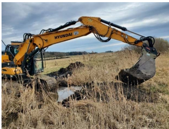
Abbildung 26: Der Einbau des Dammes muss in den Torfkörper erfolgen, dafür wird Torf seitlich und in der Tiefe entfernt. Bei dem Einsatz von Maschinen muss auf ein geringes Eigengewicht geachtet werden.
