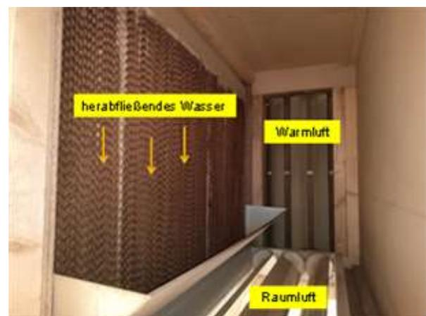
*Abb.: Kühlpad zum Einstellen der richtigen Belüftungsluft*
