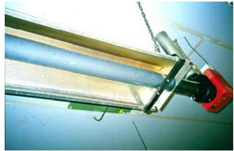
Bild 1: Brenner, Strahlungsrohr und reflektierender Schirm
