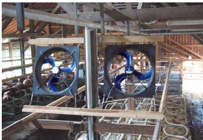
Ventilatoren im Milchviehstall Grub
