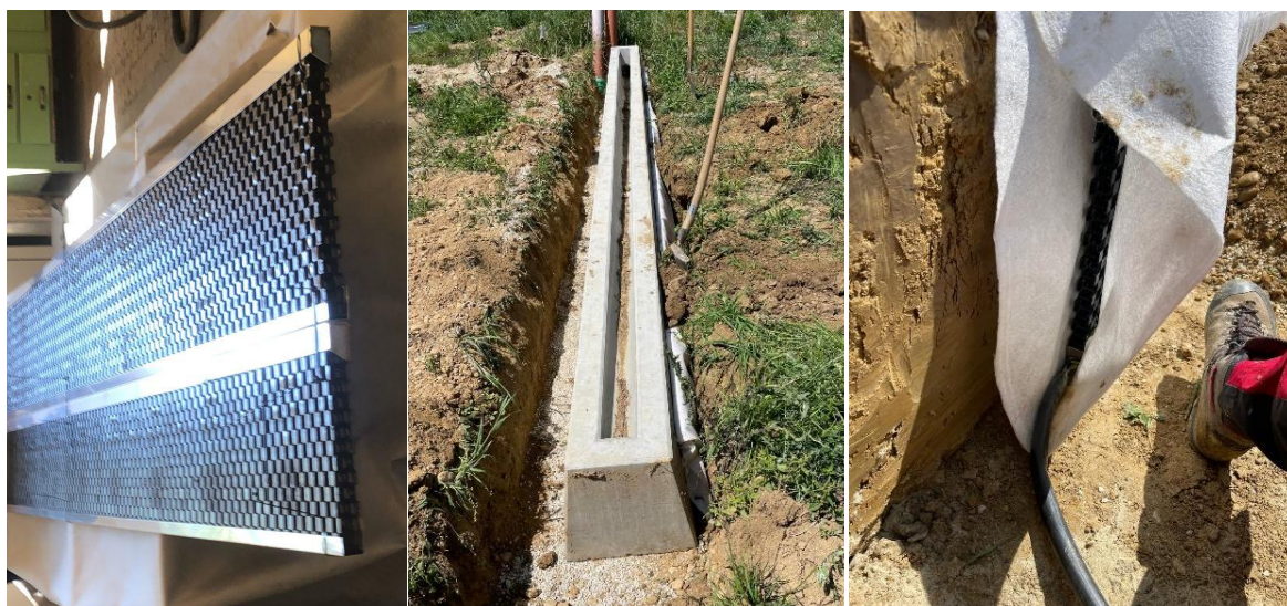
Aufbau der Drainagen Matten mit zwei Ebenen (links), eingebaute Spule mit Drainagen-system (Mitte), Anschluss des Drainagen Systems am Leitungssystem (rechts)
