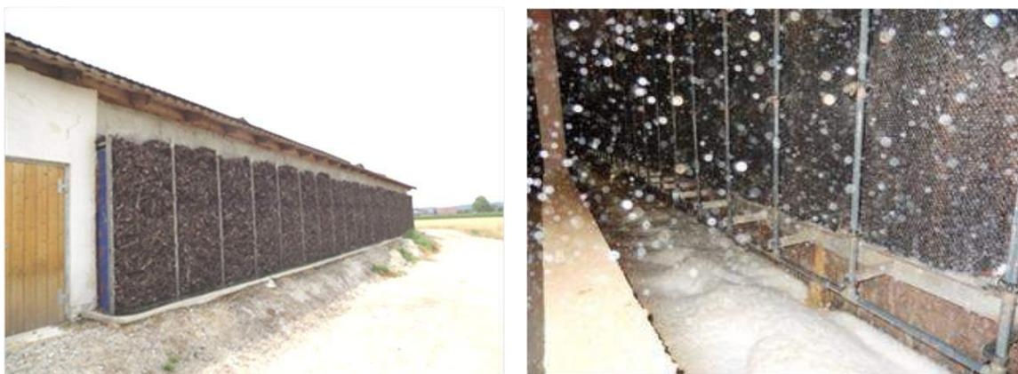
*Mehrstufige Abluftreinigungsanlage (links: Außenansicht, rechts: Innenansicht)*
