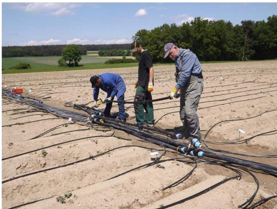
*Aufbau einer Parzellenversuchsanlage zur Tropfbewässerung*
