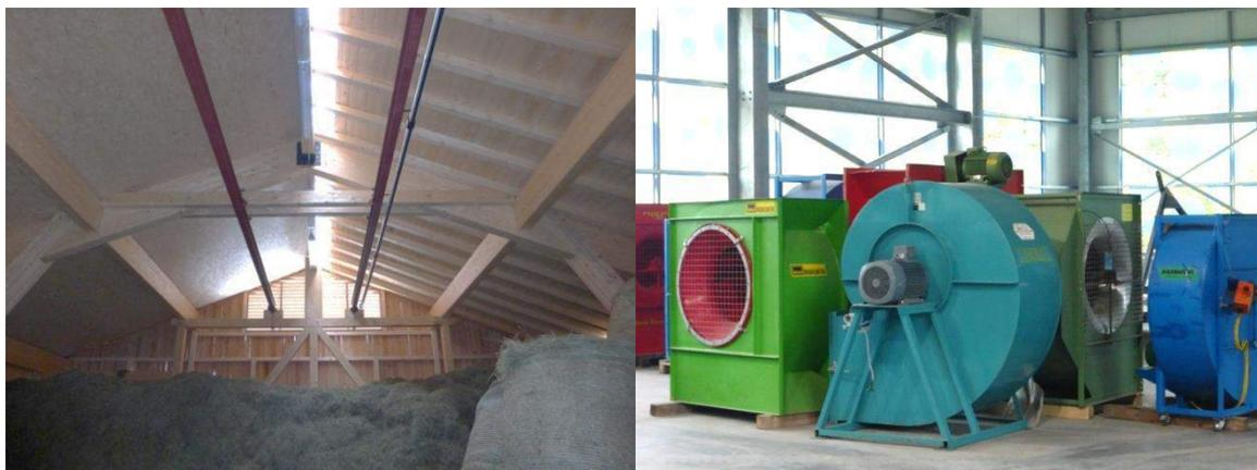
*Heubelüftungsboxen mit Bergekranschienen (links) und Radialventilatoren (rechts)*
