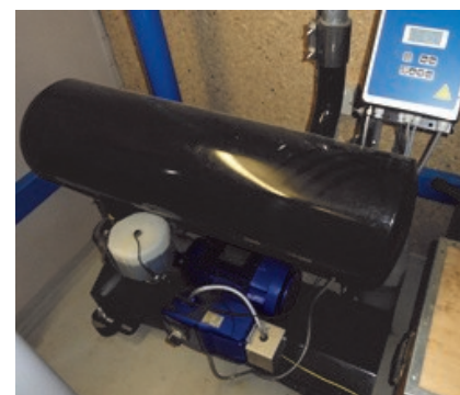
Frequenzgeregelte Vakuumpumpe
