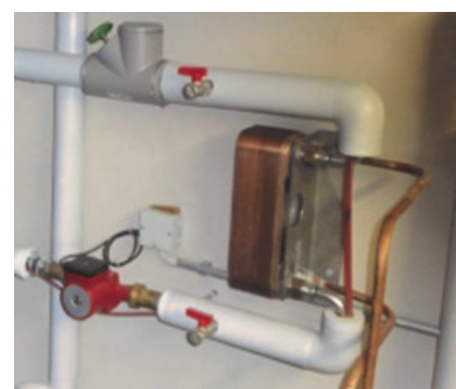
Plattenwärmetauscher
