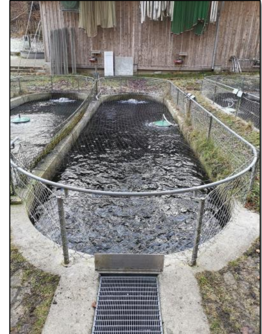
Versuchsteich aus Beton auf der Teichanlage des IFI
