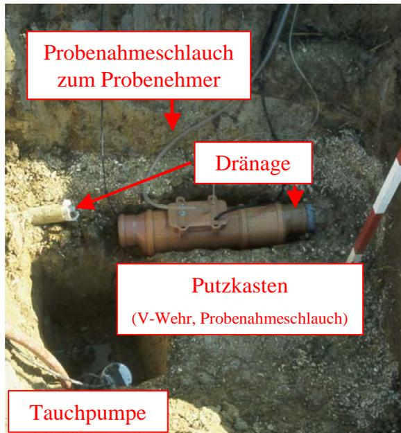
Abb. 9: Abflussmessung und Probenahme am Drän
