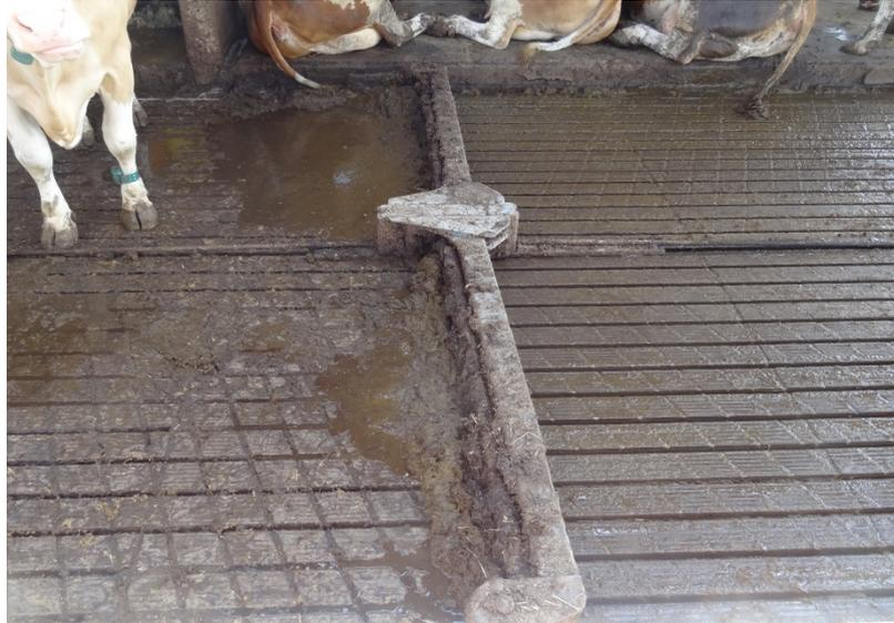
Abbildung 2: Bleiben nach dem Abschieben stark verschmierte Laufflächen (rechts), steigen die Ammoniakemissionen (Quelle: LfL; ILT 2)
