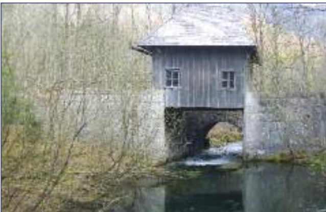
Die Triftklausen Seehaus wurde in den Jahren 1765/66 errichtet. Steinerne Klausen waren wichtige Stauwerke im Salinen-Forstbezirk um Reichenhall. Durch die Öffnung der Klausentore konnte das Holz mit einem Schwall zu Tal gelassen werden. Das in den Wäldern um Seehaus eingeschlagene Holz wurde von hier bis Traunstein getriftet und diente der Saline als Brennholz für die Salzgewinnung. Holztrift war in den Alpen weit verbreitet. Die letzte Trift fand am Seehaus am 15. Juni 1896 statt.
