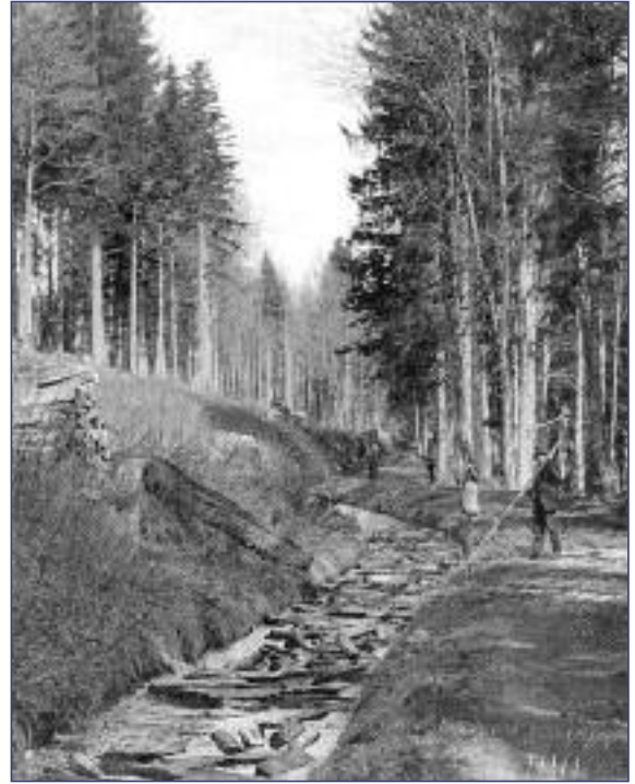
Der Schwarzenbergische Schwemmkanal - hier eine Aufnahme aus dem Jahr 1900 - verlief vom Böhmerwald nach Wien. Er wurde bis 1961 genutzt. An der ganzen Kanalstrecke standen Tag und Nacht Trifter bereit, um die Holzstücke mit langen Stangen weiter zu treiben und um ein „Verspießen“ zu verhindern.
