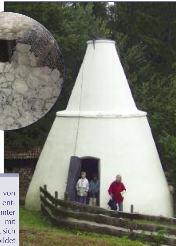
Im Freilichtmuseum Glentleiten wurde ein historischer Kalkofen nachgebaut. In der Brennkammer sind Kalksteinbrocken aufgeschichtet. Ein Brand dauerte vier bis fünf Tage.
