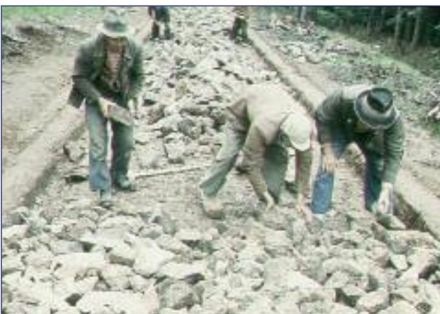
Bis ins 19. Jahrhundert produzierte die Forstwirtschaft v.a. Brennholz, das meist auf zweirädrigen Karren über Erdwege aus dem Wald geholt wurde. Während der Industrialisierung wurde dann aber auf Bauholzerzeugung umgestellt. Die alten Erdwege wurden mit Steinlagen (Makadam-Bauweise) befestigt, um die höheren Lasten tragen zu können. Die Aufnahme zeigt Waldarbeiter bei Ruhpolding, die noch in den 1950er Jahren diese Wege von Hand bauten.
