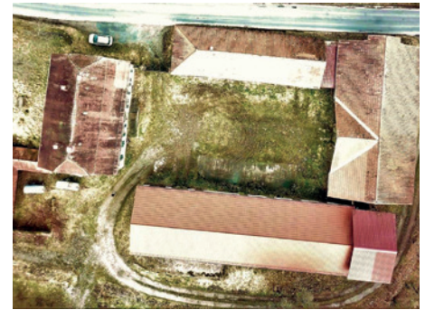
3 Das Hofgut Erlenfurt ist ein denkmalgeschützter Vierseithof, der künftig als Standort für das Eichenzentrum Hochspessart mit Akademie »Wald und Gesellschaft« dient. Foto: R. Kornder, AELF Karlstadt
