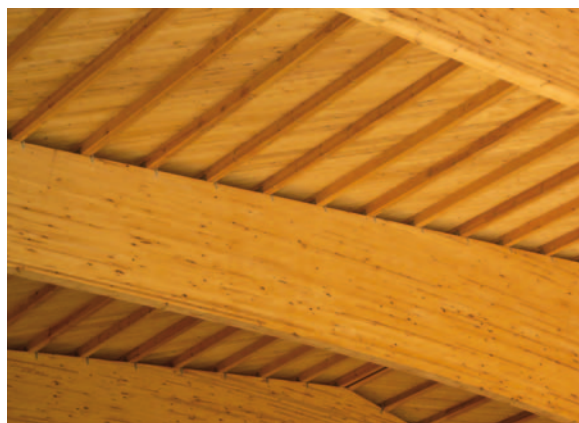
Abbildung 6: Brettchichtträger aus Kiefer (Foto: Klenk AG, Oberrot)
