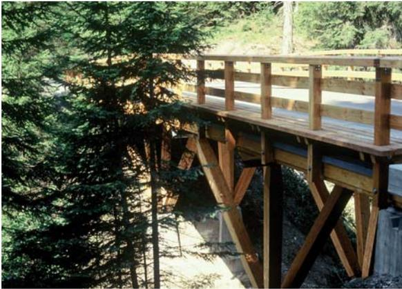
Abbildung 5: In Ingenieurbauweise ausgeführte Holzbrücke in einem Naturschutzgebiet; im Brückenbau gehört die Lärche auf Grund ihrer großen Tragfähigkeit und hohen natürlichen Dauerhaftigkeit zu den bevorzugten Holzarten. (Foto: W. Teetz)
