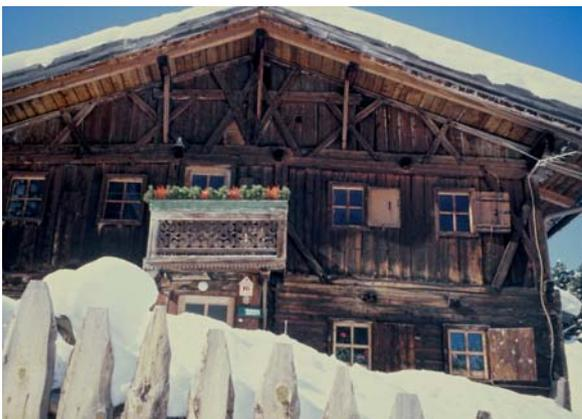
Abbildung 6: Im voralpinen und alpinen Raum mit seinen natürlichen Lärchenvorkommen kennt man seit eh und je die hervorragende Eignung des Lärchenholzes als Bauholz für Außenwände, Dachkonstruktionen, Bekleidungen, Balkone und dergleichen. (Foto: Archiv Holzforschung München).
