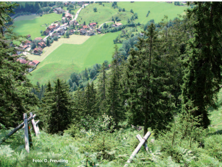
Abbildung 1: Sanierungsfläche mit Dreibeinböcken oberhalb des Dorfes Hinterstein.
