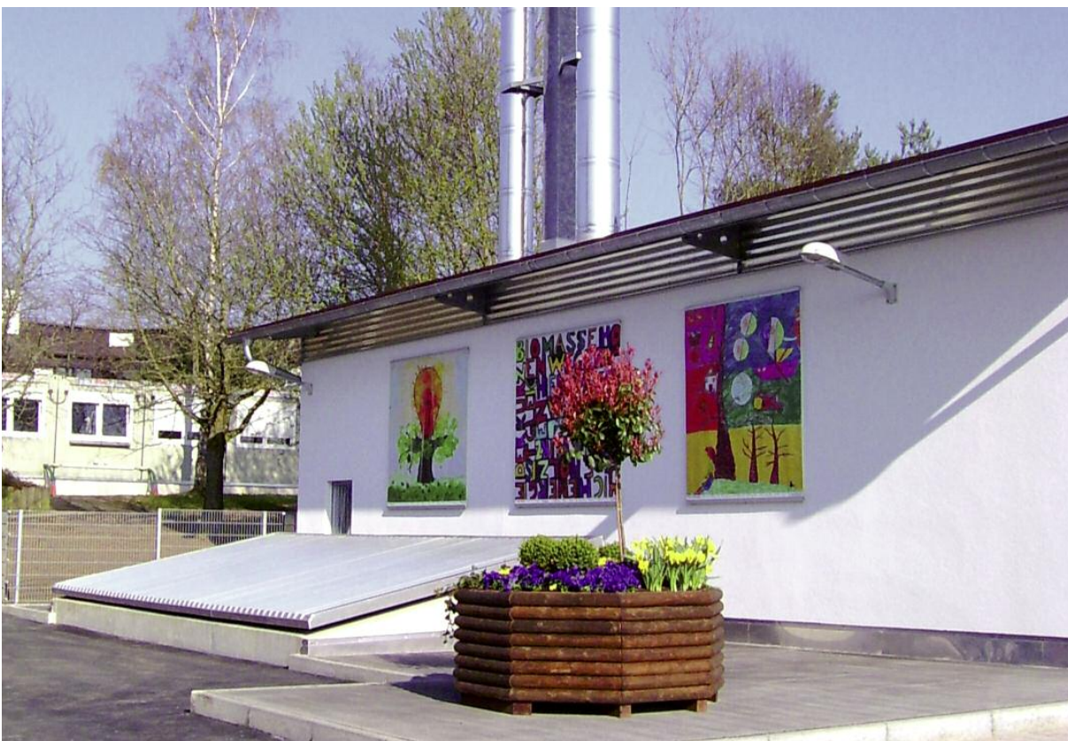
Abbildung 35: Biomasseheizwerk für das Schulzentrum in Wertingen, Lkr. Dillingen a. d. Donau (Foto: C. Rappold)
