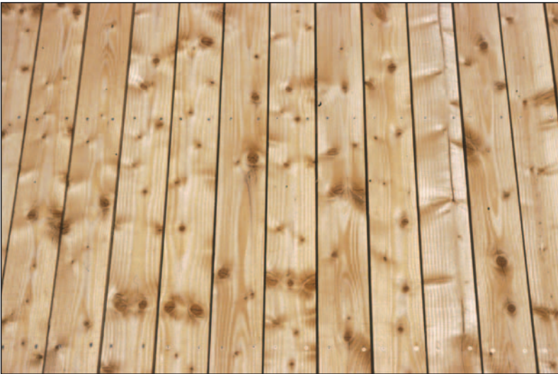
Abb. 4: Hochwertige Tanne als Fassade (Foto: Lutze)
