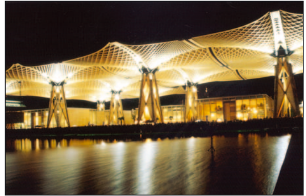
Abb. 4: EXPO-Dach, größte freistehende Holzkonstruktion, die es je gab – getragen von 40 bis zu 300 Jahre alten Tannen aus dem Schwarzwald; Abmessungen ihrer Stämme: Mittlerer Zopfdurchmesser bei 17 m: 74,1 cm o.R.; mittlerer Durchmesser Stammfuß: 102,3 cm; mittlerer Stamminhalt: 10 Fm vor Abbund; Gewicht nach der Trocknung: ca. 6 t; Länge für den Einbau: 16,10 m (Foto: N. BURGER, München)
