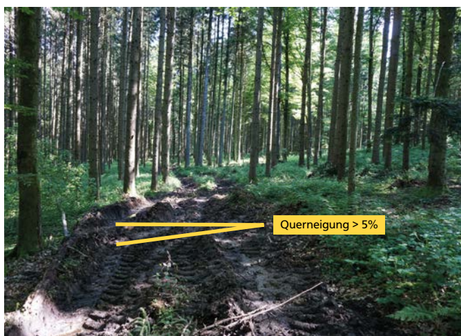
So nicht: Ein kurvier Gassenverlauf und eine zu hohe Querneigung führen zu starken Bodenschäden.
