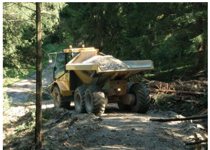
Materialtransport zur mechanischen Bodenverbesserung durch Muldenkipper.
