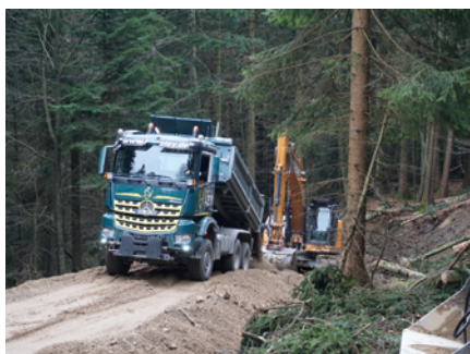
Einbau des Tragschichtmaterials
