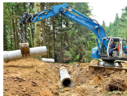
Zusammenfügen der Durchlassrohre
