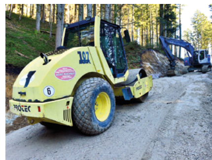
Verdichten der Deckschicht
