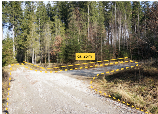
Wendehammer am Ende eines Stichweges
