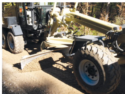
Profilieren der Deckschicht mit Grader
