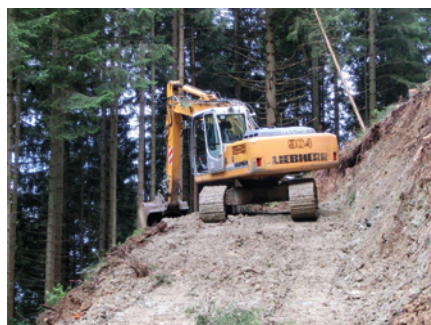
Herstellen des Rohplanums
