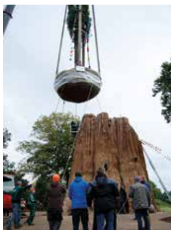
Vorsichtig positioniert der Kranführer den jungen Mammutbaum über der Öffnung des »General Sherman Tree«-Modells, um ihn anschließend in das im Inneren vorbereitete Pflanzloch hinunterzulassen. Foto: Markus Blohm
