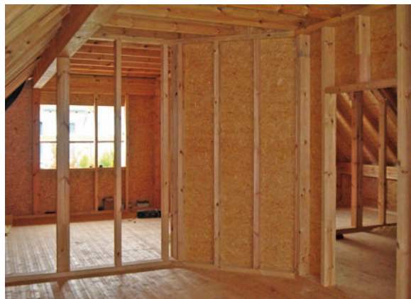
Abbildung 5: Mit Kiefer ausgebautes Dach eines Wohnhauses (Foto: Klenk AG, Oberrot)
