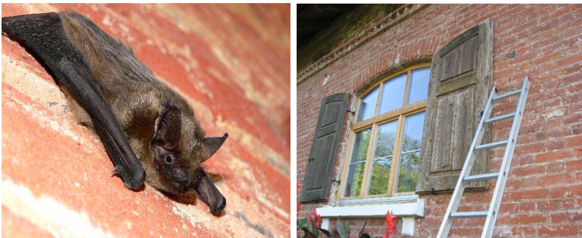
Abb. 69 und 70: BreitflügelFledermaus und Tagesquartier hinter Fensterläden am Forsthaus Schlott.
