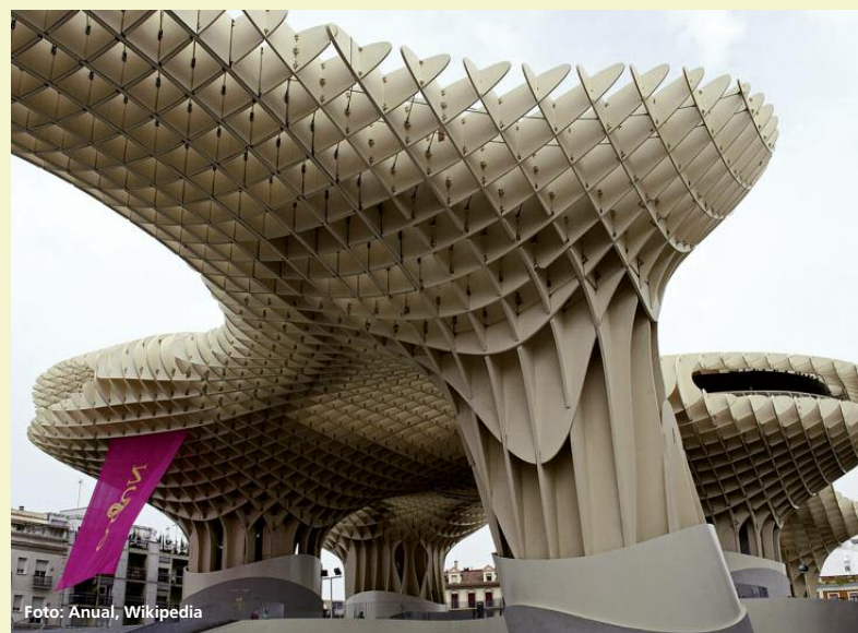
Abbildung 6: Der Metropol Parasol in der spanischen Stadt Sevilla ist 150 m lang, bis zu 75 m breit und 28 m hoch und somit eines der größten Holzbauwerke der Welt.
