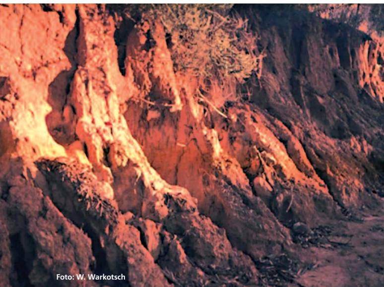
Abbildung 2: Falsche Wegebaumaßnahmen waren vielfach von zum Teil massiven Erosionen begleitet und die Wege häufig in einem sehr schlechten Zustand.
