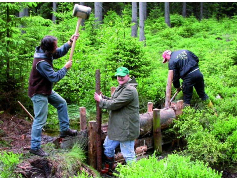
Abbildung 4: Entwässerungsgräben sind Gift für die Moore. Das Verschließen der Gräben ist eine wichtige Maßnahme in der Moorrenaturierung. (Foto: E. Lisges, Biolog. Station Rothaargebirge)
