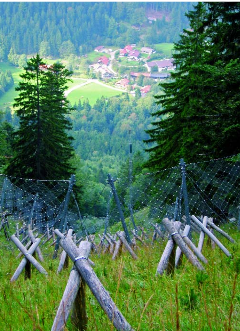
Abbildung 2: Technische Verbauungen zum Schutz vor Lawinen und Schneegleiten kosten bis zu 500.000 Euro pro Hektar. (Foto: P. Dimke)
