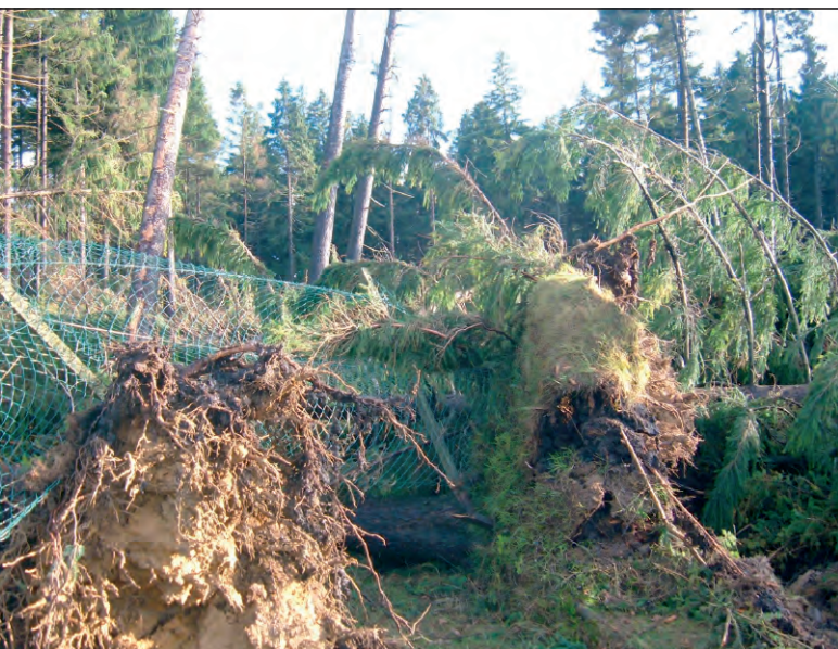
Abb. 2: Schwer beschädigte Orkan Kyrill die Messfläche Lehtenbach des Bayerischen Landesamtes für Umwelt im Fichtelgebirge. Die bayerischen Waldklimastationen kamen bis auf die WKS Ebrach mit einem blauen Auge davon. In Ebrach zerstörte Kyrill fast die gesamte Instrumentierung. (Foto: U. Wunderlich)
