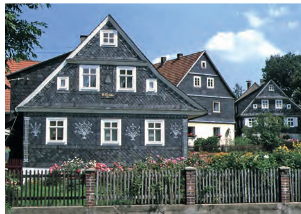
Schieferverkleidete Häuser im Frankenwald
