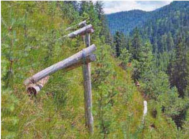
Abbildung 65: Temporäre Verbauungen mit Dreibeinböcken schützen die Aufforstungen. (Foto: Dietrich Zerneck)
