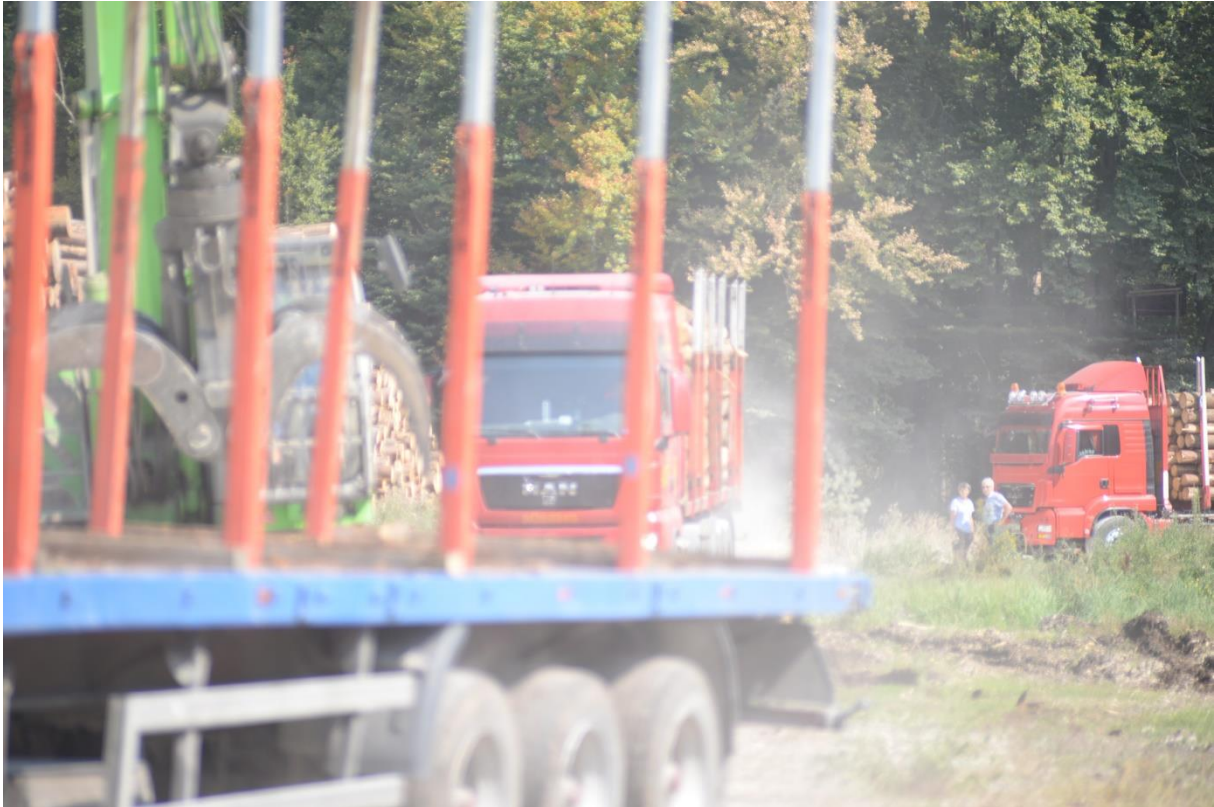
Abbildung 11: Der Wegebau muss einer temporär hohen Belastung standhalten.
