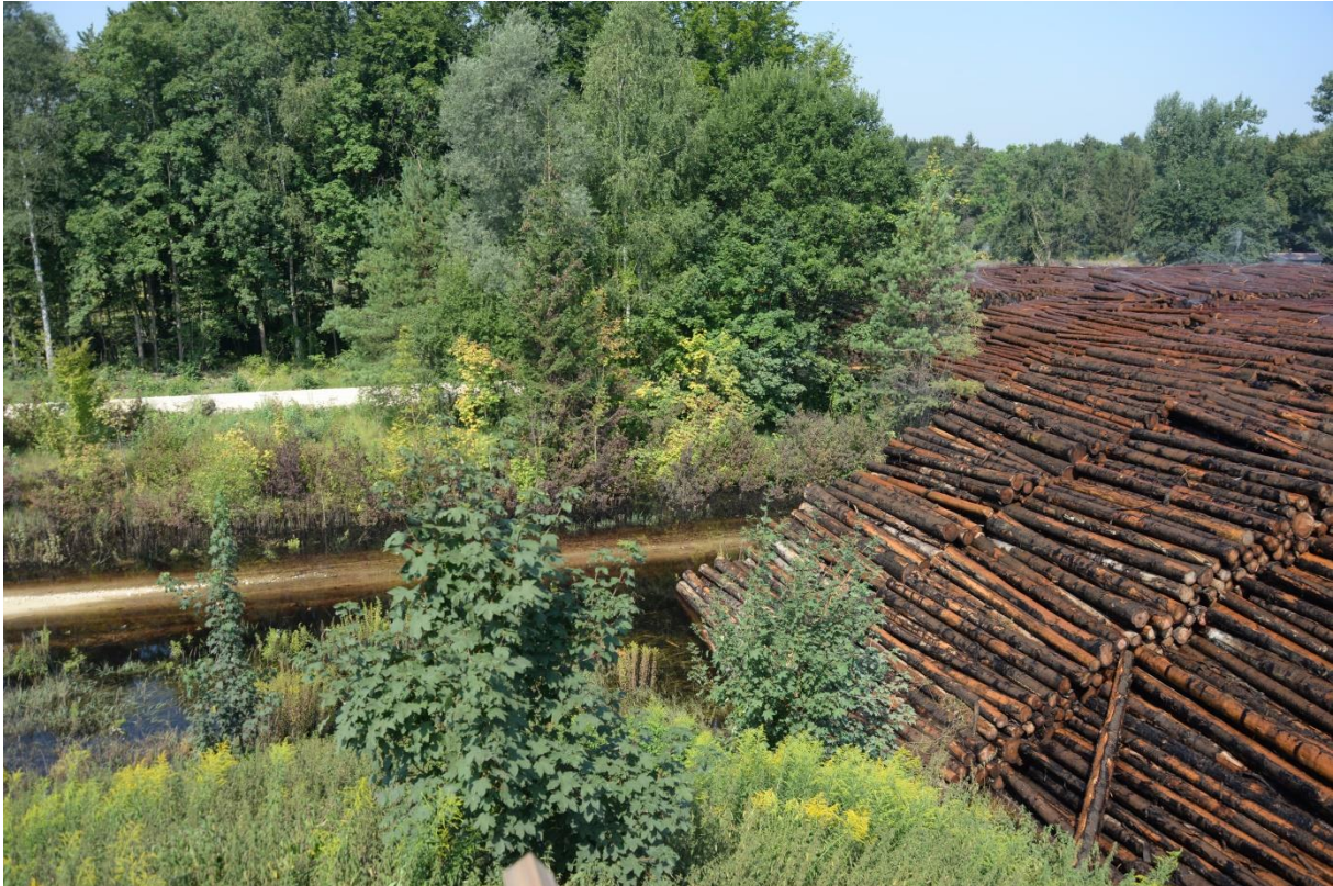
Abbildung 13: Das geht besser! Überschwemmter Weg im trockenen Hochsommer. Offensichtlich Ergebnis unzureichender Planung und eines nicht optimalen Wasserabflusssystems.
