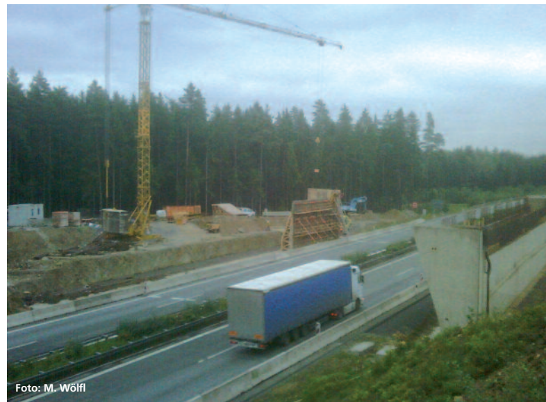
Abbildung 1: A 93 Rehauer Forst – Bau einer Grünbrücke im Rahmen des Konjunkturpakets II (Stand September 2010)
