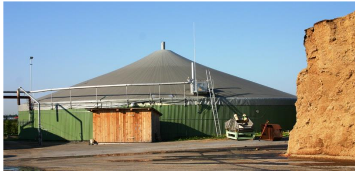
Abb. 59: Biogasanlage mit NaWaRo-Verwertung
