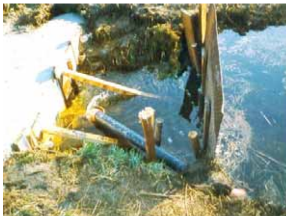
Fertigstellung des Ablaufes mit einbetonier- tem Kunststoffrohr
