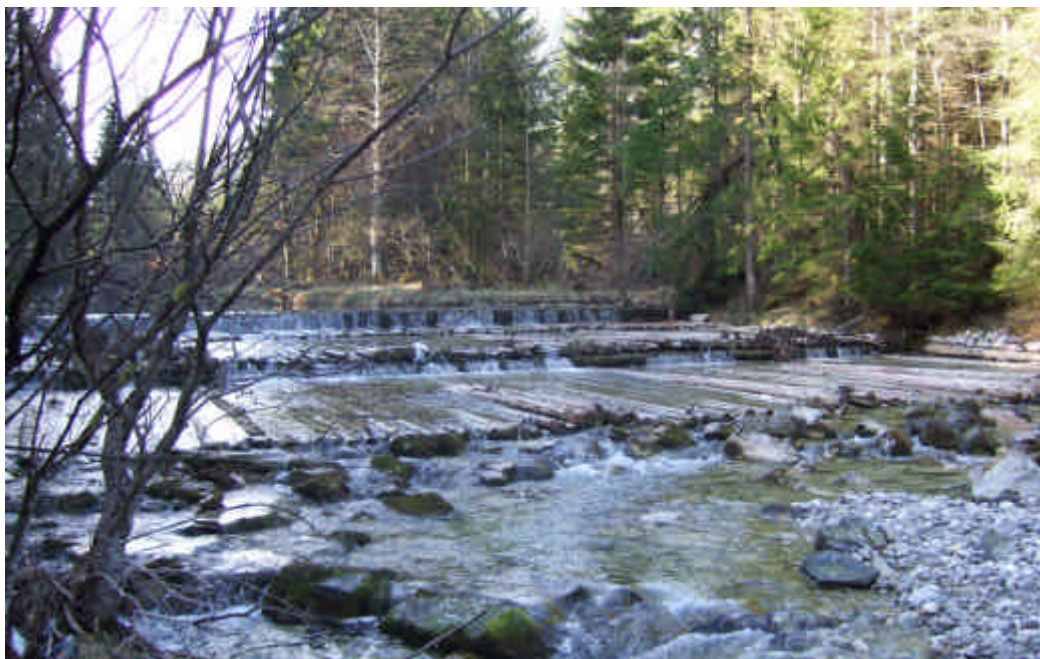
Querbauwerke verhindern den Aufstieg von Seeforellen
