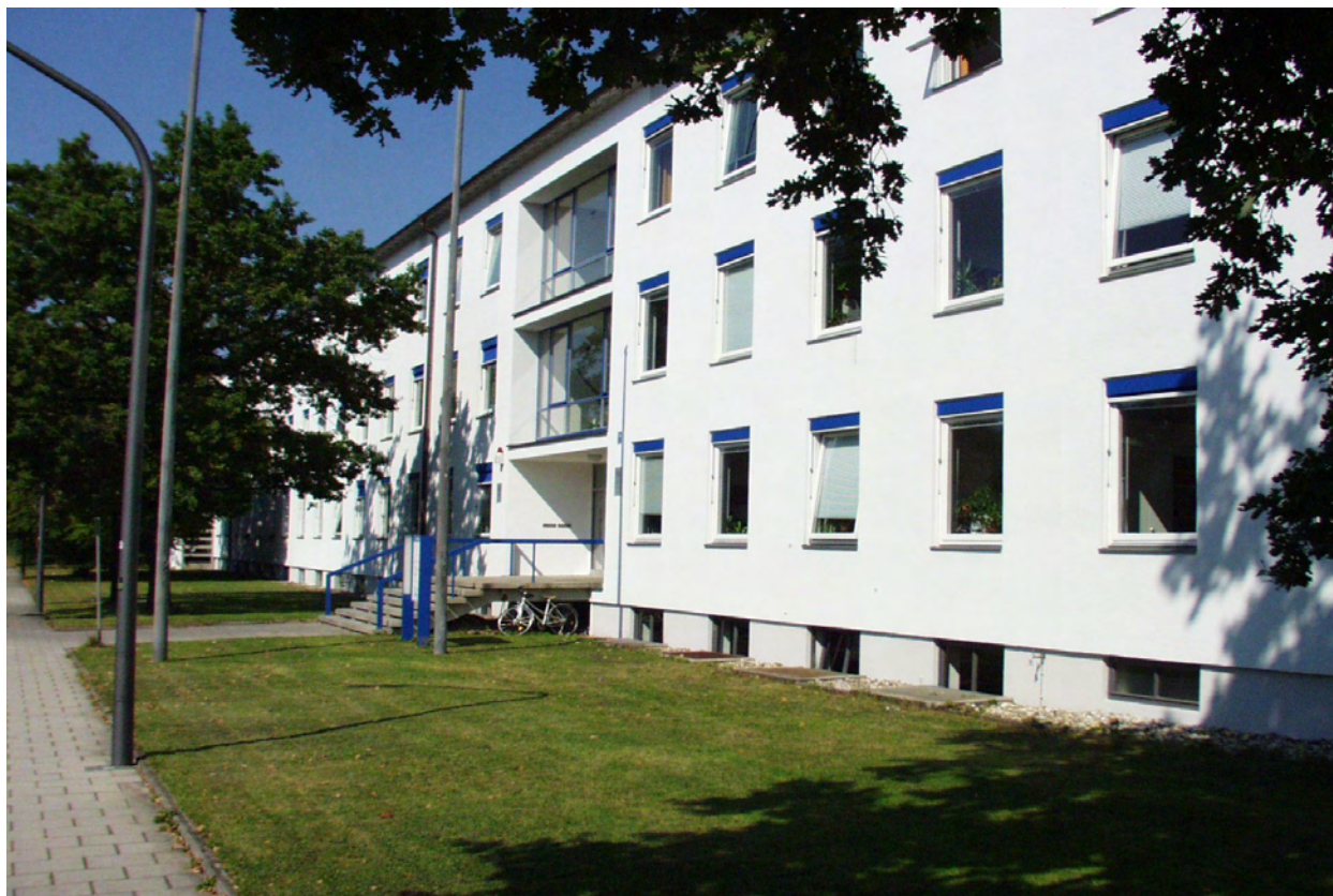
Abb. 1: Das Dienstgebäude, Menzinger Straße 54, D-80638 München (Das Institut befindet sich im Erdgeschoss)
