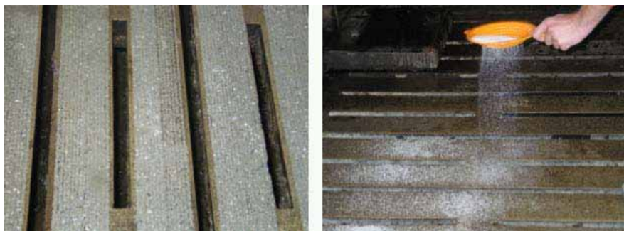
Längsrillen nach dem Fräsen, Aufbringen von pulverförmiger Zitronensäure
