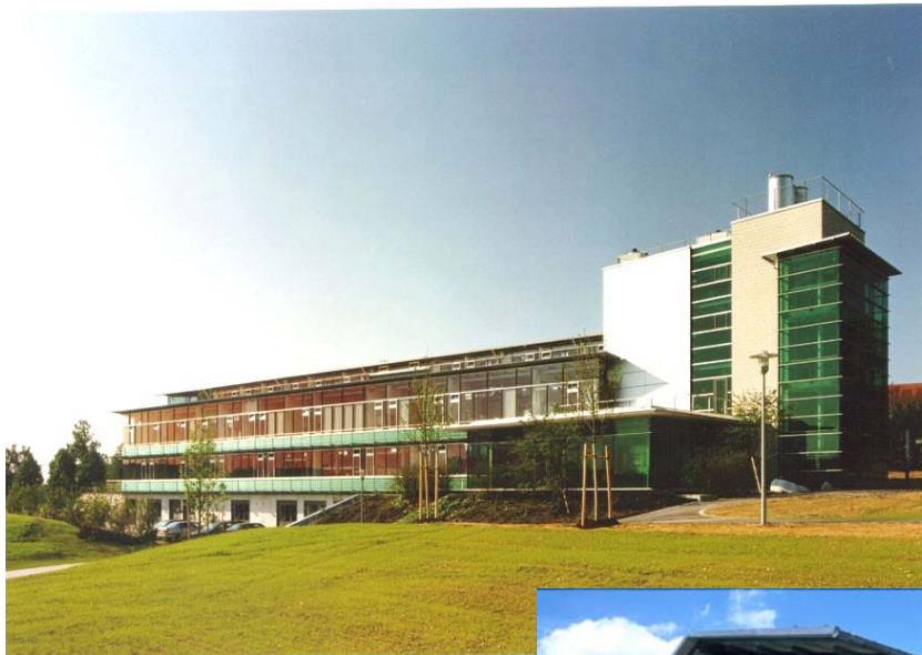
Institutsgebäude an der Langen Point 10
