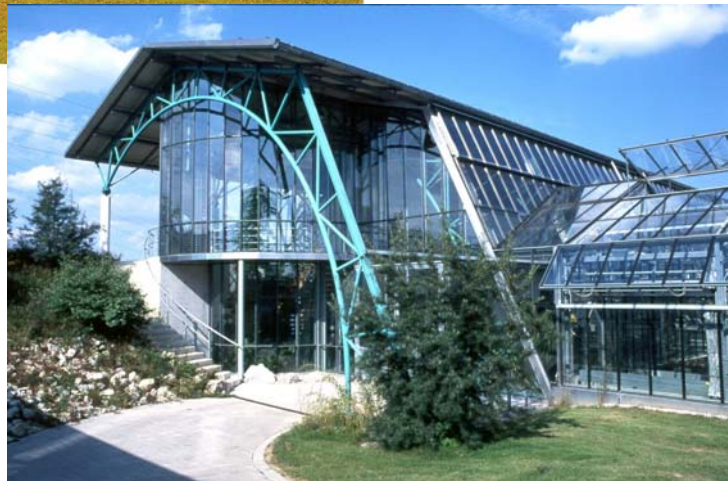
Technologie-Gebäude des IPS
