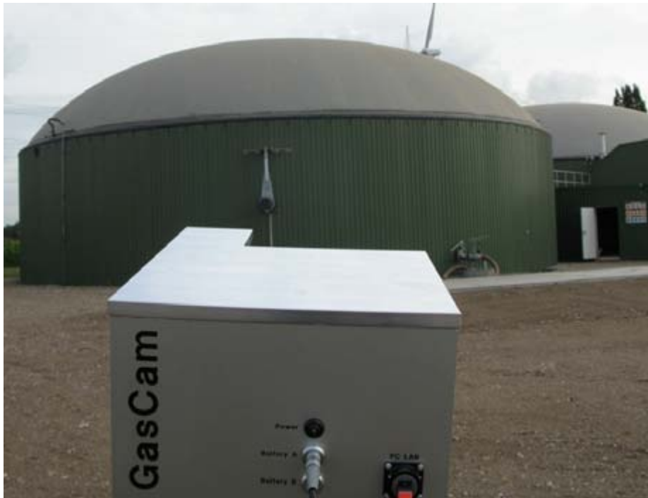
Abb. 1: Blickwinkel und Aufstellung bei einer GasCam Messung (Quelle: Fa. Esders)
