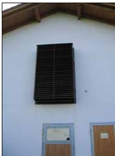
Abb. 19: Nordseitiger Lufteintritt in den Zentralgang des Stalles
