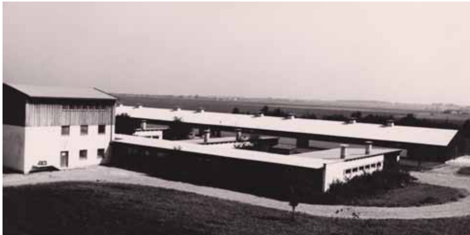
Abb. 2: MPA Grub mit erstem Erweiterungsbau im Jahre 1960
