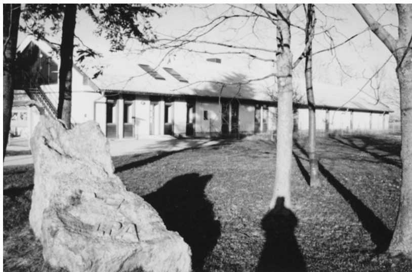
Abb. 4: Bau des Stichprobenteststalls im Jahr 1991
