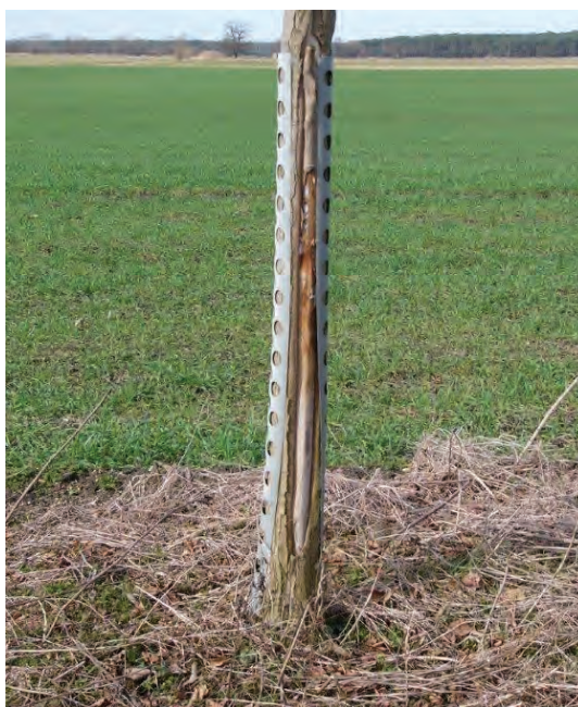
Abb. 7: Vergessen! Fehlende Hinterlüftung einer auf der Rinde aufliegenden Plastemanschette führt zur deutlichen Temperaturerhöhung und einem Rindenschaden. Das Risiko ist höher als auf der ungeschützten Rinde! Foto: Jeschke (links und rechts)
