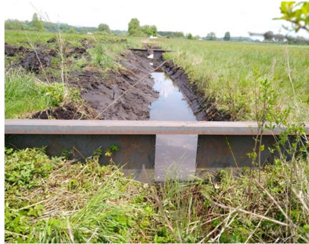
Einbau von Stauwehren im Freisinger Moos.
