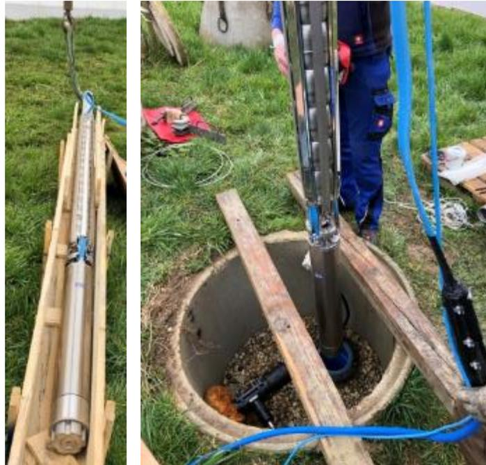
*Abb. 3.5: Unterwasserpumpe und Einbau in einen Tiefbrunnen.*
