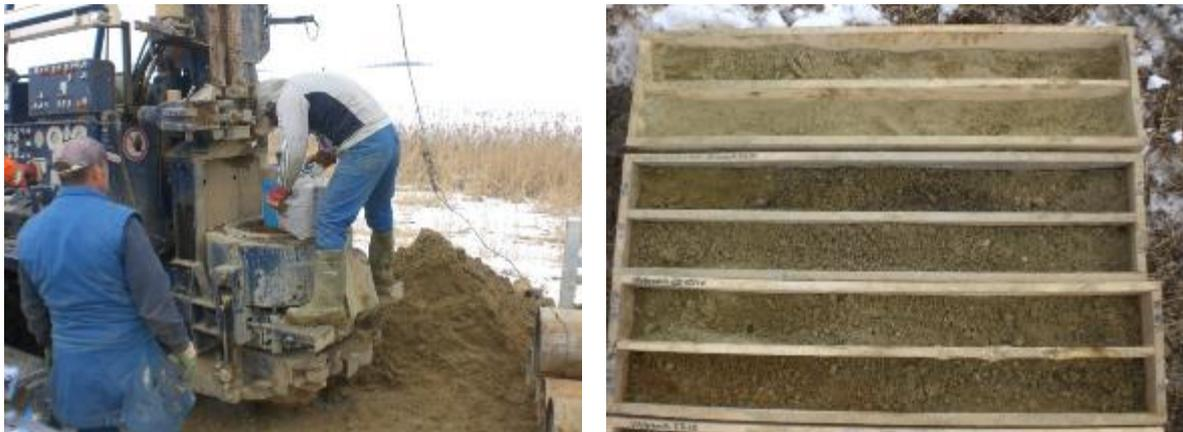
*Abb. 3.3: Errichtung eines Tiefbrunnens im trockenen Rammkern-Bohrverfahren.*
