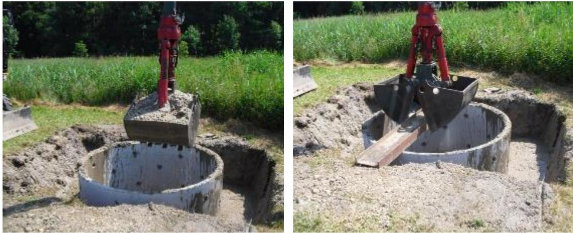
*Abb. 3.2: Errichtung eines Schachtbrunnens.*
