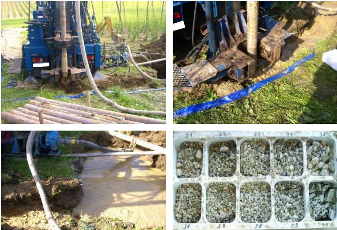
Abb. 3.4: Errichtung eines Tiefbrunnens im Nass- bzw. Spülbohrverfahren.
