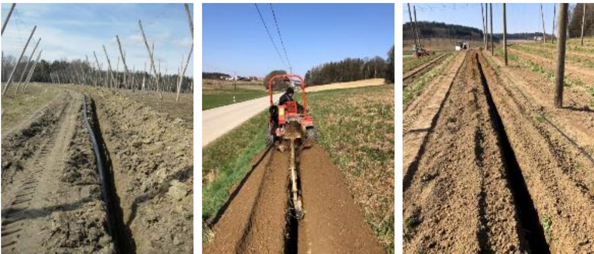
Abb. 3.9: Errichtung eines Hauptleitungsnetzes mit Grabenfräse und Minibagger.
