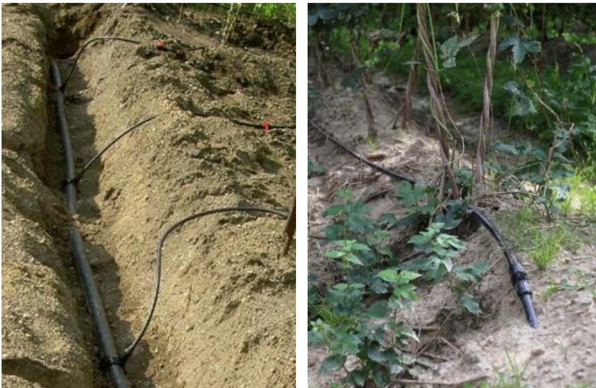
*Abb. 3.11: Unterirdische Errichtung der Kollektorleitung.*
