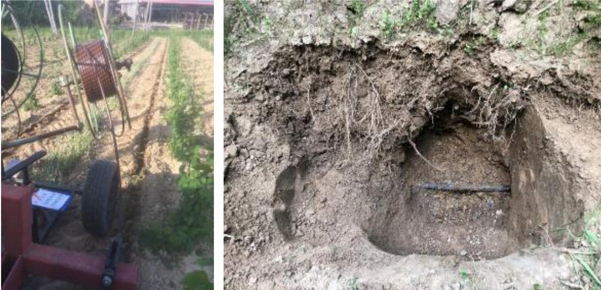
*Abb. 3.15: Unterirdische Installation des Tropfschlauches neben dem Bifang.*
