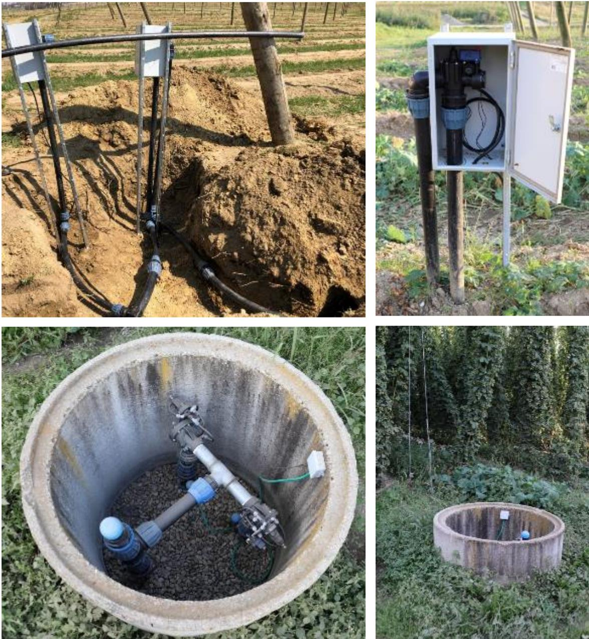
*Abb. 3.10: Errichtung einer Ventilstation in einem Elektroinstallationskasten oder einem Schachtring*
